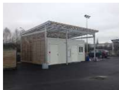
Remplacement du local gardien
