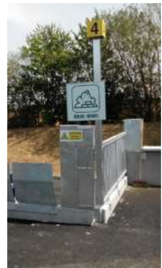
Mise en place d'une nouvelle Signalétique
