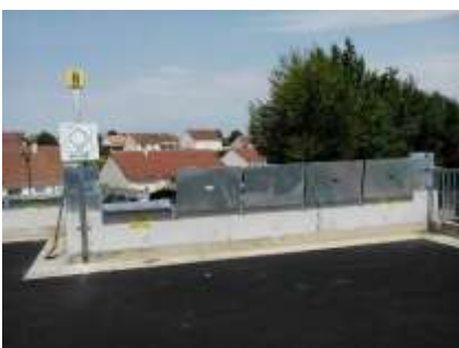
Mise en place de dispositifs antichute
