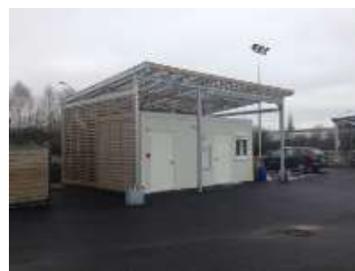
Remplacement du local gardien
