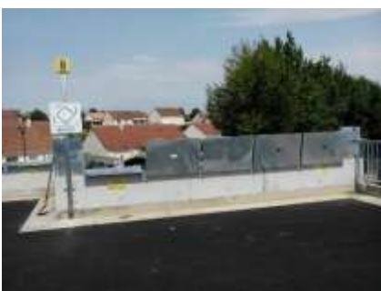
Mise en place d'un dispositif antichute
