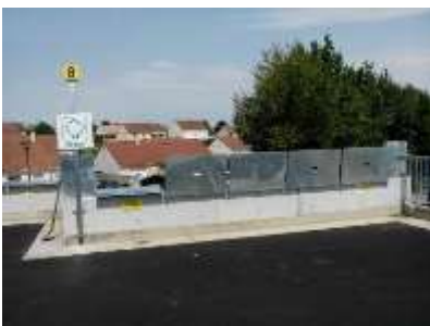
Mise en place d'un dispositif antichute
