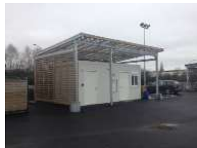
Remplacement du local gardien
