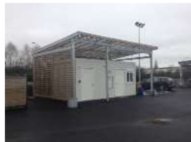
Remplacement du local gardien
