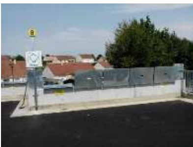
Mise en place d'un dispositif antichute
